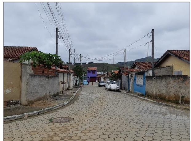
QUADRO 76 – CALÇAMENTO CAPELA DO JACU FONTE: ACERVO DO AUTOR, 2021
