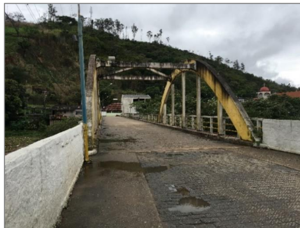
FIGURA 152 PONTE SOBRE RIO PARAÍBA FONTE: ACERVO AUTOR 2021
