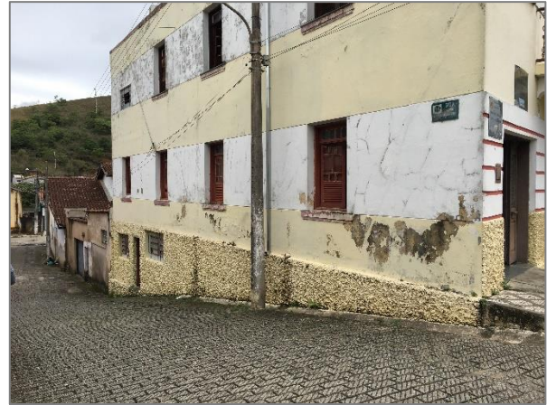
FIGURA 177 – CENTRO – VISTA 02 FONTE: ACERVO DO AUTOR, 2021
