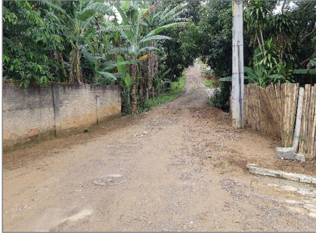
QUADRO 68 – FALTA DE PAVIMENTAÇÃO NO BAIRRO NITEROI FONTE: ACERVO DO AUTOR, 2021
