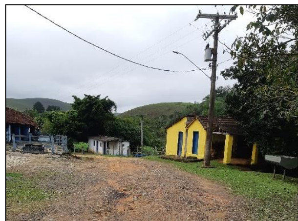
FIGURA 353 - DRENAGEM SUPERFICIAL NO BAIRRO RETIRO DOS BARBOSAS – VISTA 2 FONTE: ACERVO DO AUTOR, 2021
