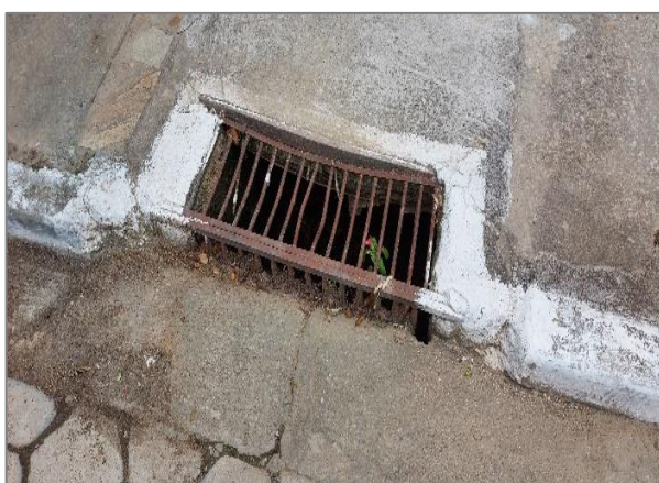
FIGURA 161 - BOCA DE LOBO NA FRENTE DO CRAS FONTE: ACERVO DO AUTOR 2021
