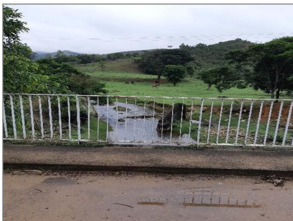
FIGURA 338 PONTE DE ACESSO BAIRRO RETIRO DOS BARBOSAS FONTE: ACERVO DO AUTOR 2021
