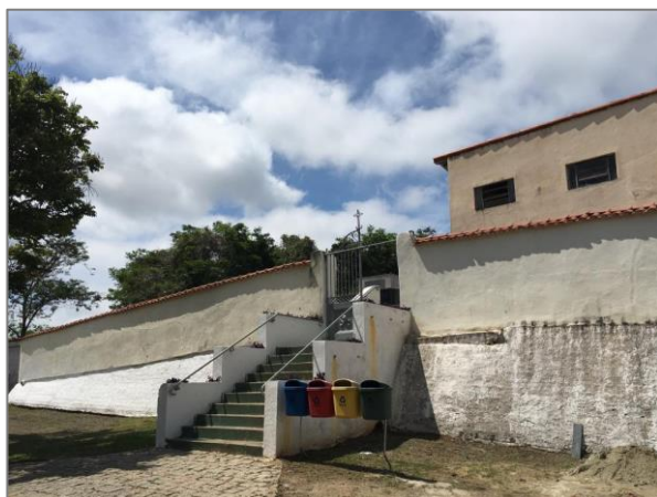
FIGURA 207 – CEMITÉRIO MUNICIPAL FONTE: ACERVO DO AUTOR, 2021
