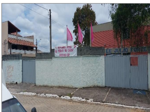
FIGURA 201 – EE JÚLIO FORTES FONTE: ACERVO DO AUTOR, 2021
