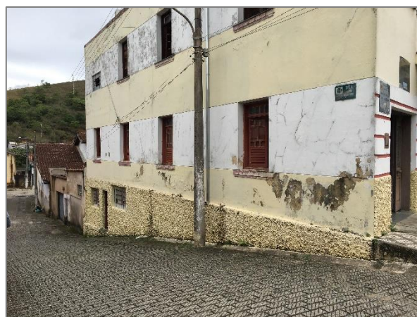
FIGURA 334 – CENTRO – VISTA 02 FONTE: ACERVO DO AUTOR, 2021
