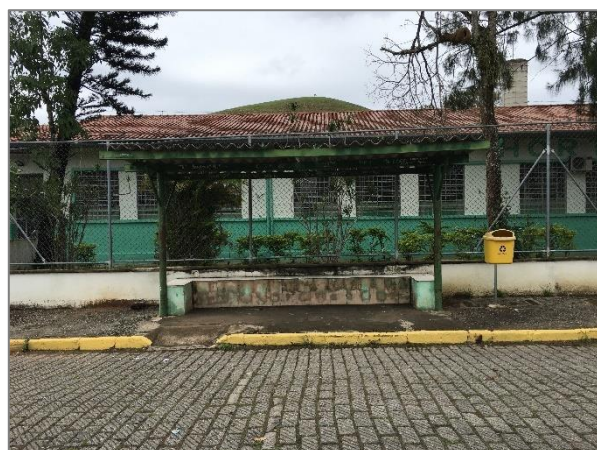
FIGURA 183 – PONTO RUA MANOEL MACHADO FONTE: ACERVO DO AUTOR, 2021
