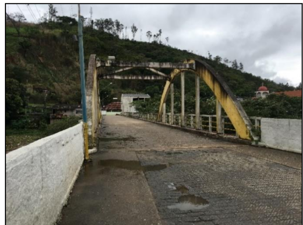
FIGURA 337 PONTE SOBRE RIO PARAÍBA FONTE: ACERVO AUTOR 2021
