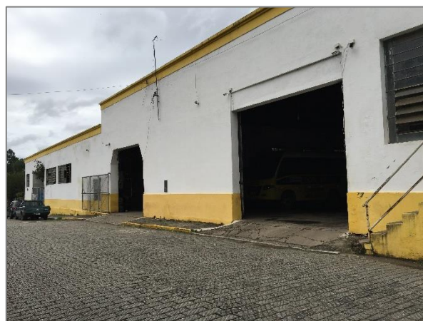
FIGURA 362 – GARAGEM MUNICIPAL FONTE: ACERVO DO AUTOR, 2021
