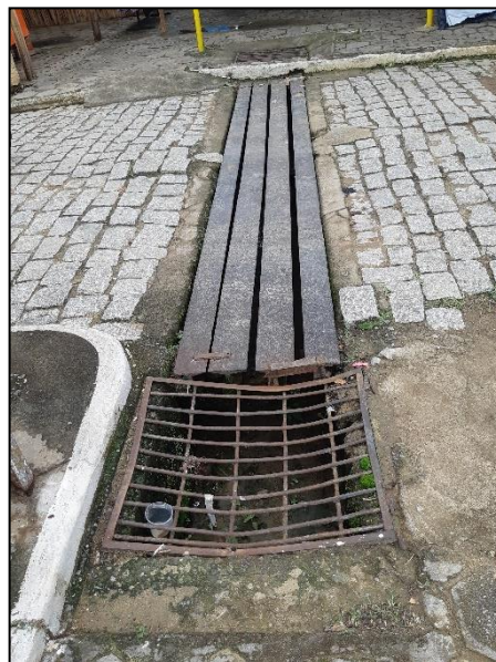
FIGURA 345 – BOCA DE LOBO PRÓXIMA A PRAÇA CAPELA DO JACU FONTE: ACERVO DO AUTOR, 2021
