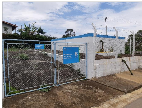
FIGURA 139 - RESERVATÓRIO CAPELA DO JACU FONTE: ACERVO DO AUTOR, 2021
