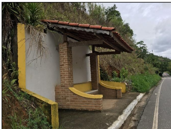
FIGURA 325 – PONTO NA RODOVIA JÚLIO FORTES FONTE: ACERVO DO AUTOR, 2021
