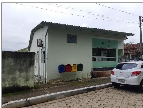
FIGURA 194 – PSF CAPELA DO JACU FONTE: ACERVO DO AUTOR, 2021
