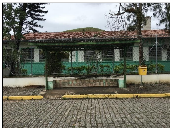
FIGURA 324 – PONTO RUA MANOEL MACHADO FONTE: ACERVO DO AUTOR, 2021
