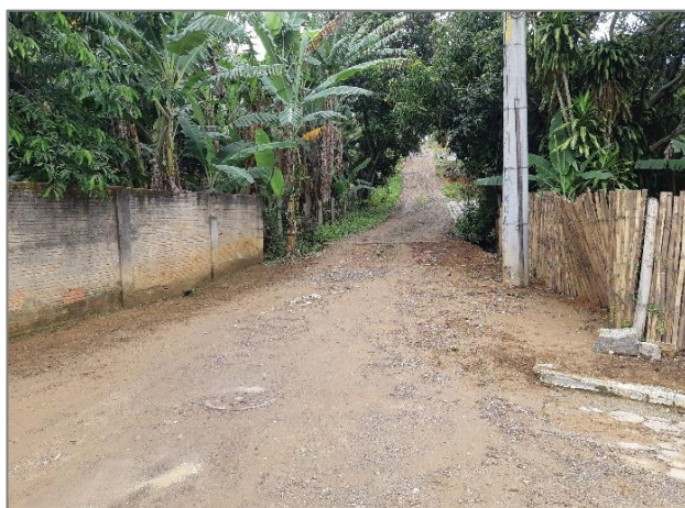
QUADRO 97 – FALTA DE PAVIMENTAÇÃO NO BAIRRO NITERÓI FONTE: ACERVO DO AUTOR, 2021
