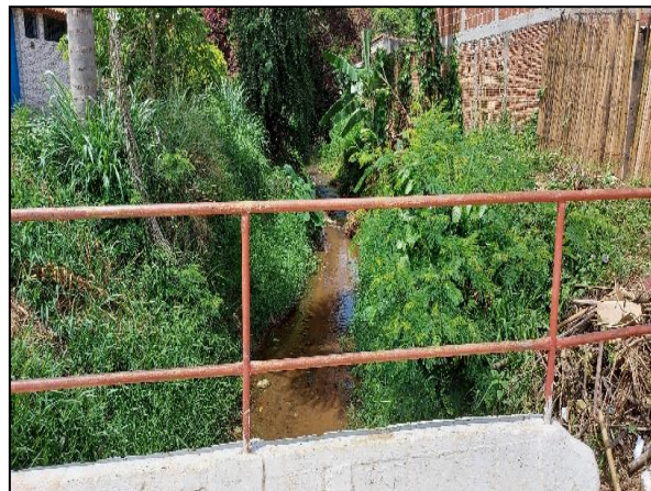
FIGURA 339 PONTE DE ACESSO BAIRRO PINHEIRINHO FONTE: ACERVO AUTOR 2021
