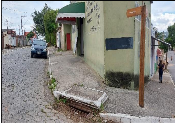
FIGURA 348 - BOCA DE LOBO NA ESQUINA DO MERC VITINHO FONTE: ACERVO DO AUTOR 2021
