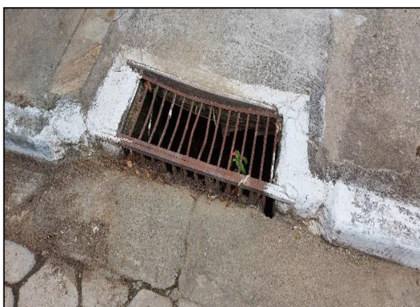
FIGURA 346 - BOCA DE LOBO NA FRENTE DO CRAS FONTE: ACERVO DO AUTOR 2021
