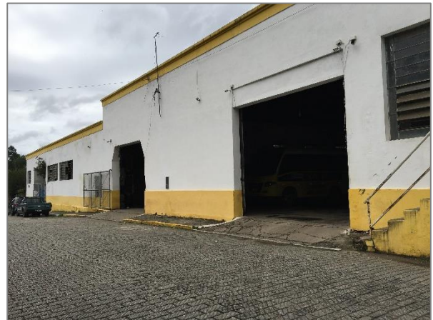
FIGURA 78 – GARAGEM MUNICIPAL FONTE: ACERVO DO AUTOR, 2021
