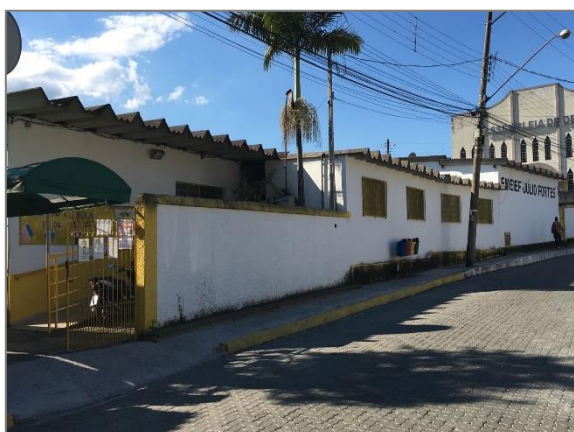
FIGURA 233 – CARTAZ INSTALADO NA ESCOLA MUNICIPAL JÚLIO FORTES - VISTA 01 FONTE: ACERVO DO AUTOR, 2021
