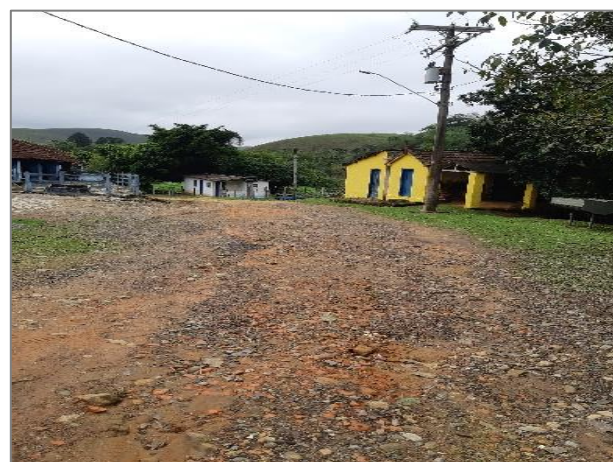
QUADRO 98 – FALTA DE PAVIMENTAÇÃO NO BAIRRO RETIRO DOS BARBOSAS FONTE: ACERVO DO AUTOR, 2021
