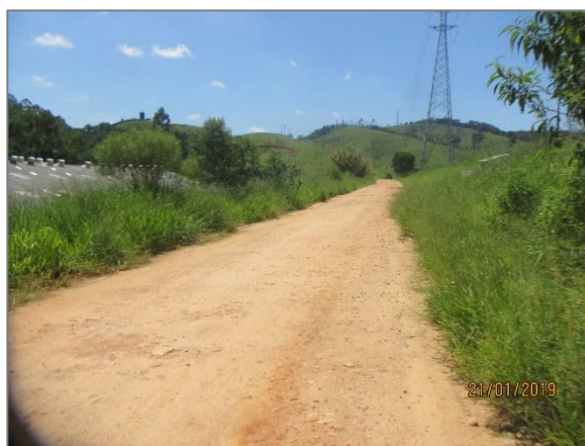
FIGURA 115 – USINA PCH – PEQUENA CENTRAL HIDRELÉTRICA DE LAVRINHAS FONTE: ACERVO DO AUTOR, 2021
