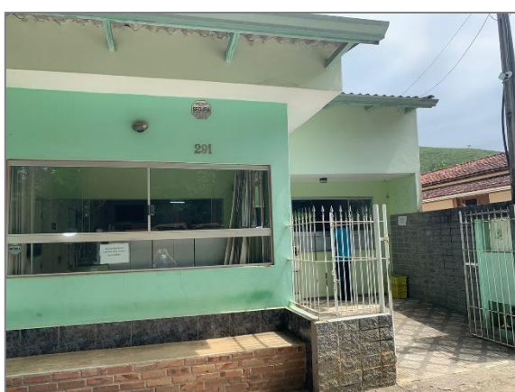
FIGURA 420 – CARTAZ INSTALADO NO PSF CAPELA DO JACU - VISTA 01 FONTE: ACERVO DO AUTOR, 2022
